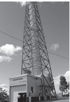
▲自社製作の無重力実験装置です。50mから落下させ約3秒間、宇宙空間のような微小重力環境を作りだします。
